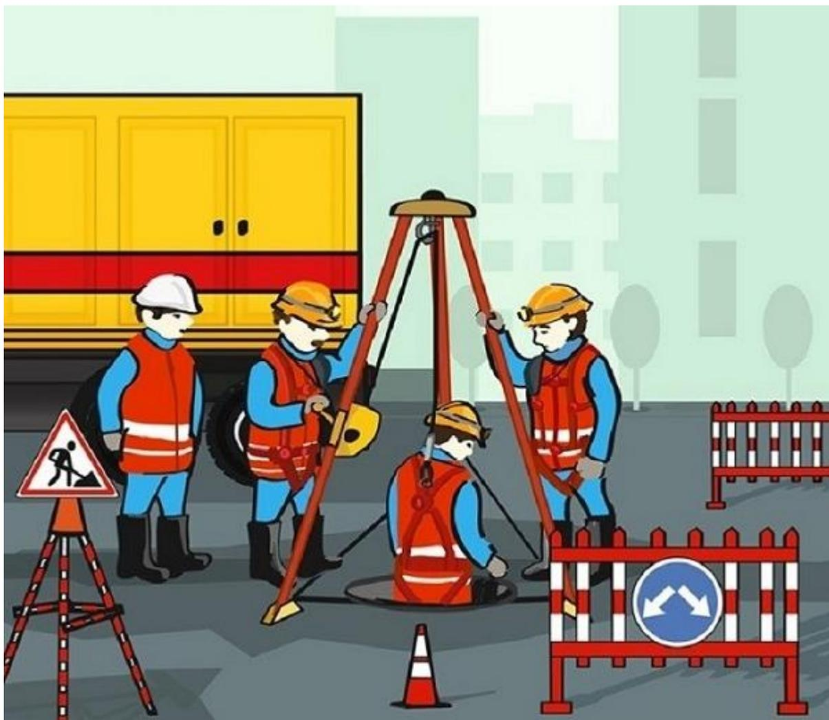
Рисунок 2. Спуск в загазованный колодец
