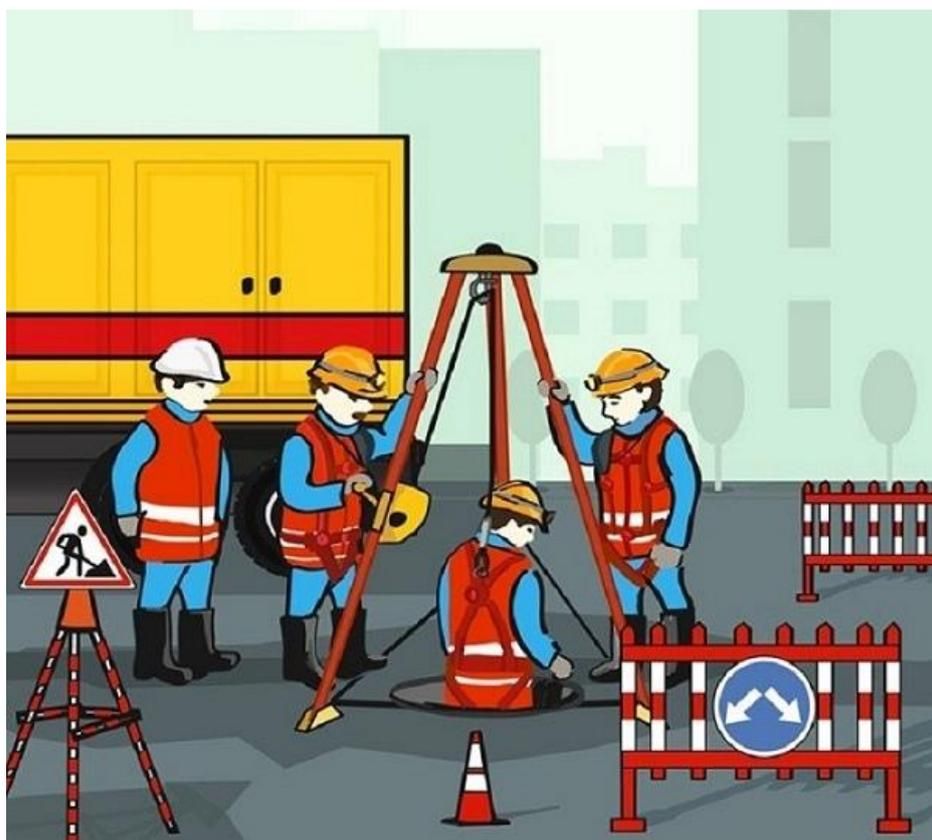
Рисунок 1. Спуск в колодец с помощью трипода
